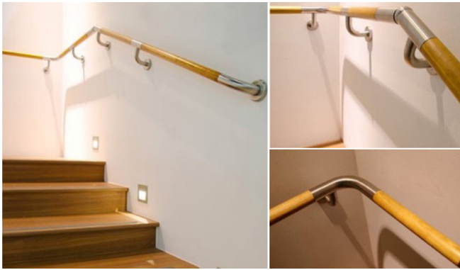
รูป: ราวจับบริเวณบันไดที่ติดตั้งเพิ่มจากราวจับเดิม
