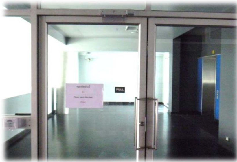
ประตูระบบ Access Control
